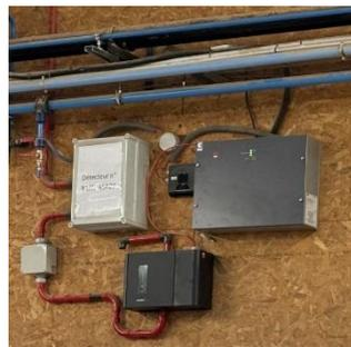
Figure 1: détecteur optique et détecteur par aspiration
