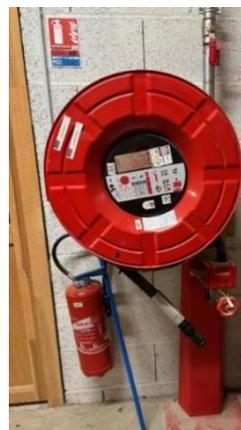
Figure 3: réserve d'eau avec système d'alimentation des RIA – RIA et extincteur
