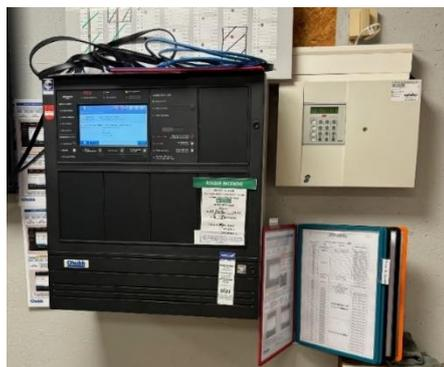
Figure 2: système de pilotage des détecteurs
